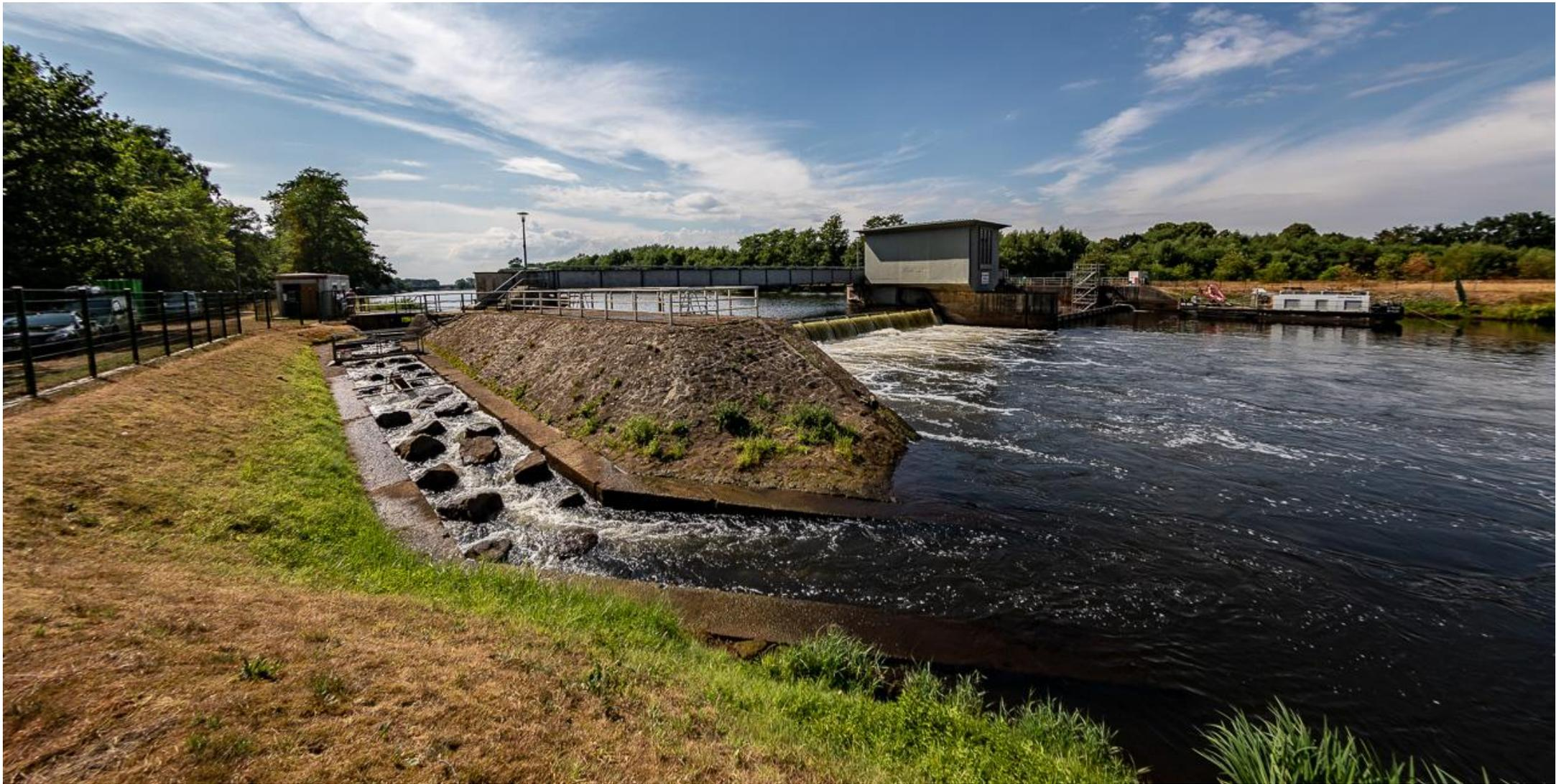
Ohne die Unterstützung durch Angler wäre hier die lange Reise für Glasaale beendet. Aufstiegsanlage für Glasaale an der Ems bei Dörpen. Foto: DAFV, Olaf Lindner
