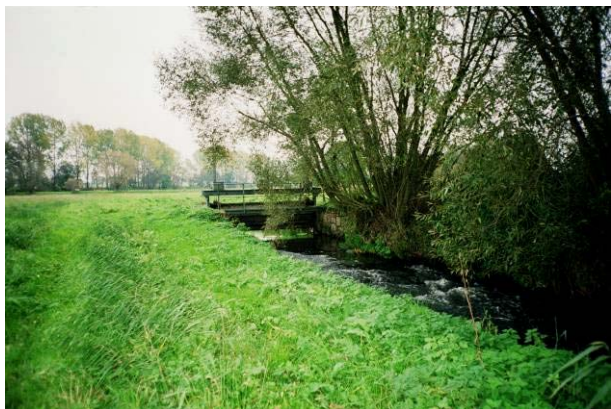
Abb. 10: Wehr Kuhbier II (Dömnitz, vorher)
