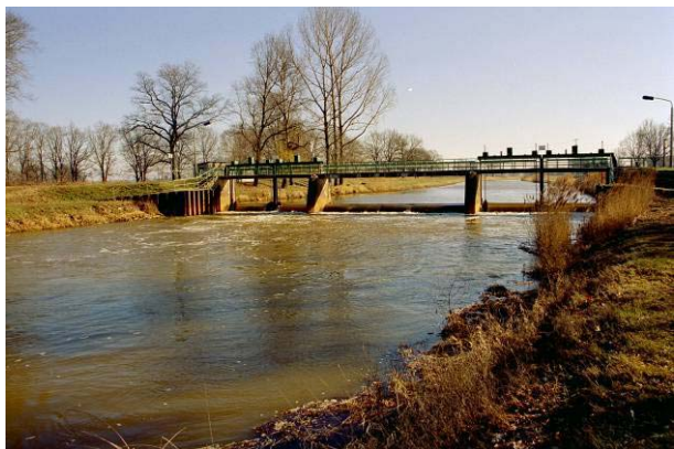
Abb. 24: Wehr Herzberg (vorher)
