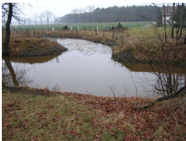
Abb. 35: Umgehungsgerinne (Oberwasser Wehr I)
