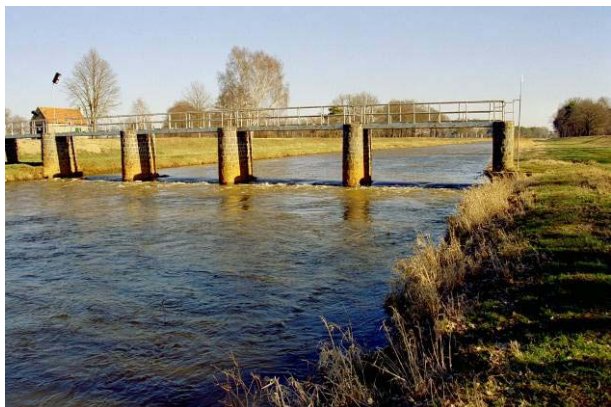
Abb. 22: Wehr Arnsnesta (vorher)
