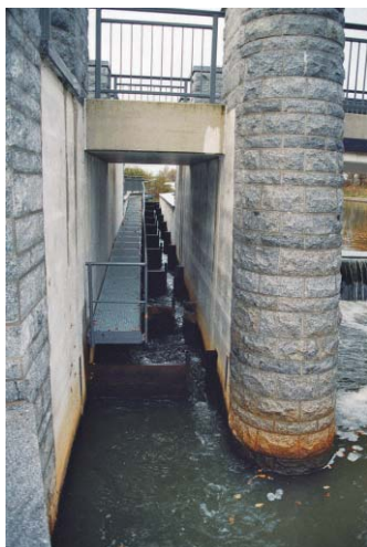
Abb. 26: Fischpass Bad Liebenwerda
