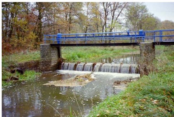
Abb. 27: Wehr Kotschka (Pulsnitz)
