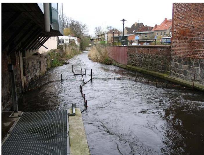
Abb. 37: Smolt-Falle in Perleberg (Betriebszustand)
