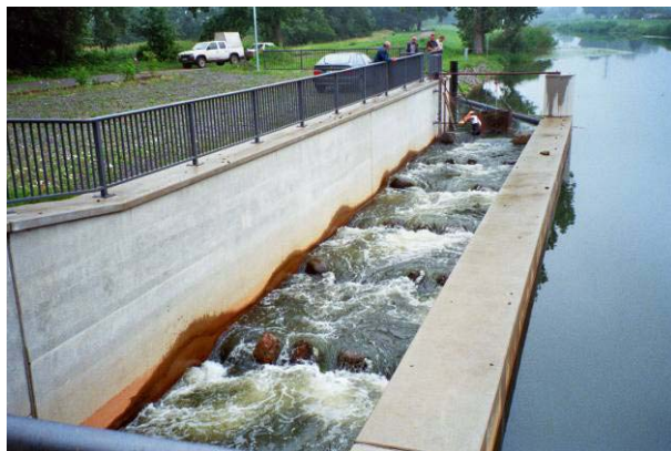
Abb. 25: Raue Rampe Herzberg (nachher)
