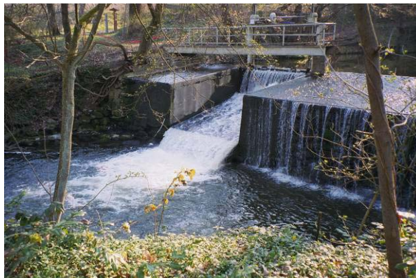
Abb. 31: Wehr Grünmetzmühle (Pulsnitz)
